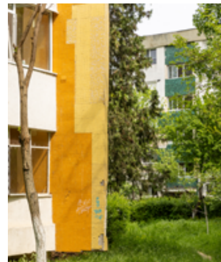
↑ Casa scării a unuiu dintre blocurile de garsoniere, cu intervenții ulterioare, imagine exterioară
