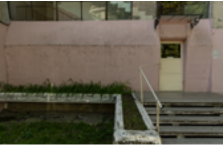
↓ Casa scării a unuia dintre blocurile de garsoniere, cu intervenții ulterioare, imagine exterioară
